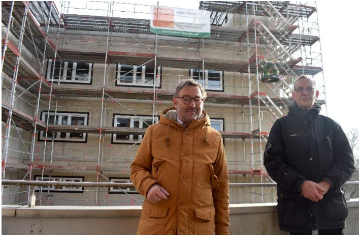
Richtfest: Krankenhausdirektor Bernhard Ziegler (li.) und Verbandsvorsteher Dr. Reinhold Wenzlaff vor der Baustelle.
