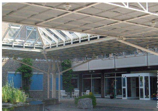
Haupteingang Klinikum Itzehoe (Haus A)
